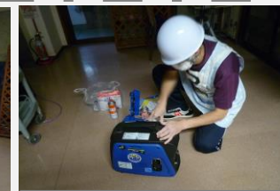
発電機稼働し電源確保
